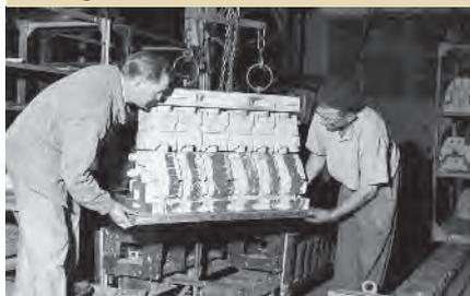
Assemblage des noyaux avant la coulée des carters-cylindres des moteurs de camions de la SAVIEM. Dpt 61, fonderie de fonte grise, 1956. © Renault Communication DR.
