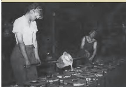
Coulée des segments et des sièges de soupapes en 1950. © Renault Communication DR.
