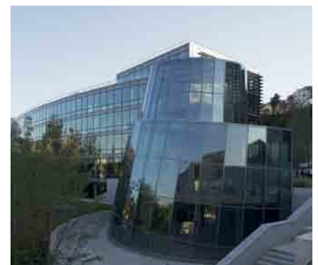
"Meudon Campus" : les immeubles de bureaux au cœur du parc paysager © Hervé Abadie
