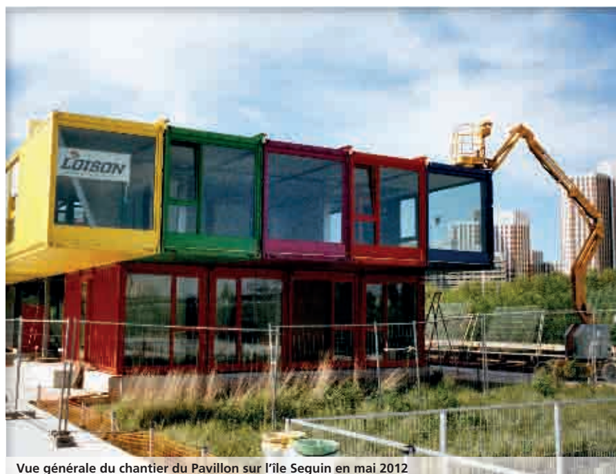
Vue générale du chantier du Pavillon sur l'île Seguin en mai 2012
